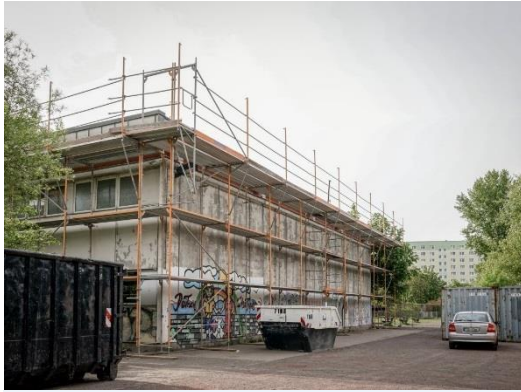
Die Schulsporthalle der Bernhard-Grzimek-Grundschule wird für ca. 1,5 Millionen Euro erneuert
